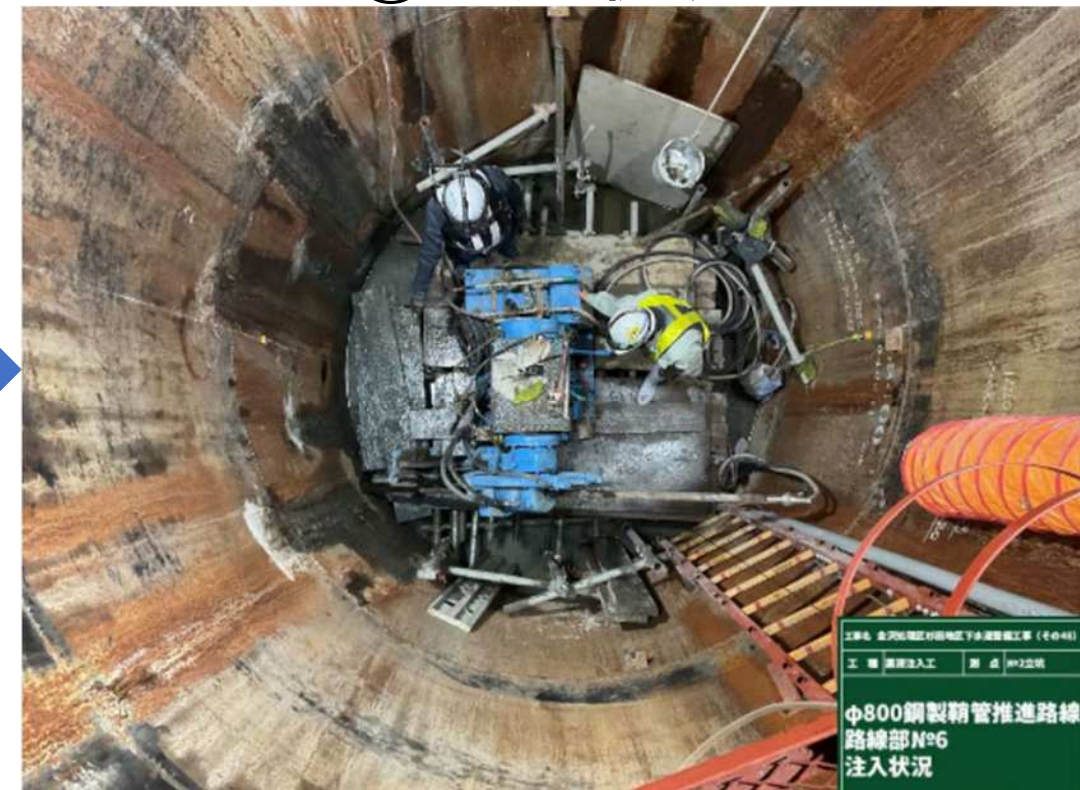
②注入状況
