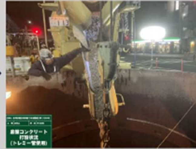
コンクリート打設
