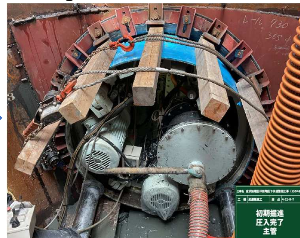
⑦掘進機主管推進
