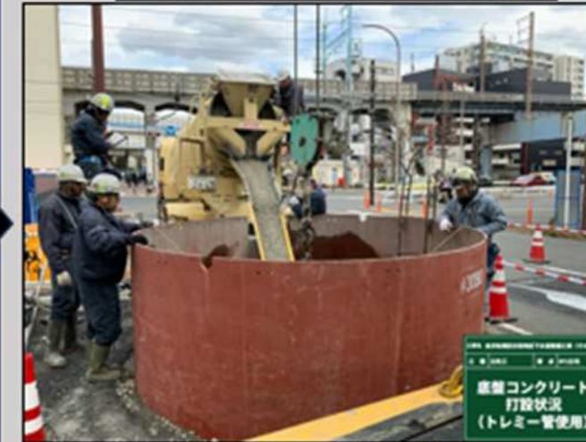
コンクリート打設
