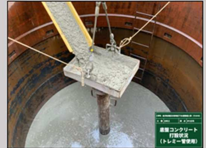
コンクリート打設
