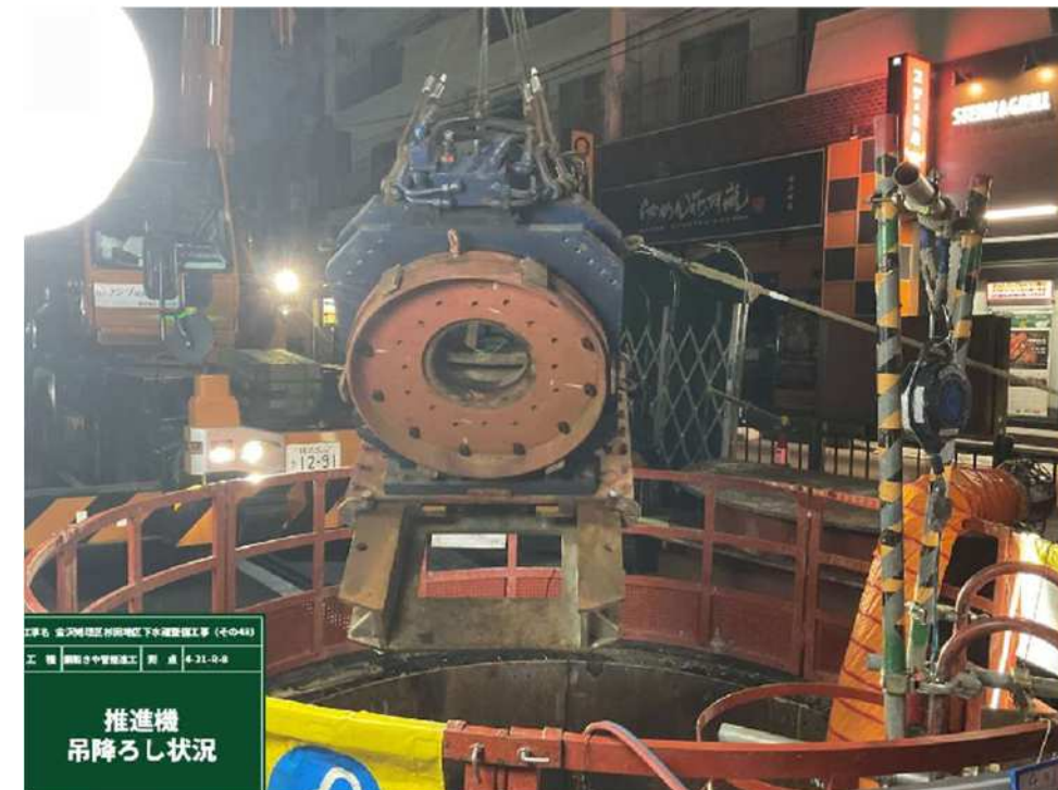
② 推進機吊降ろし
