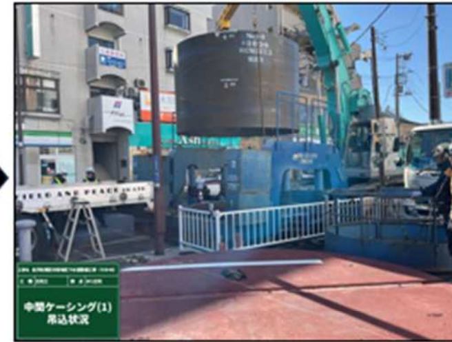
ケーシング設置
