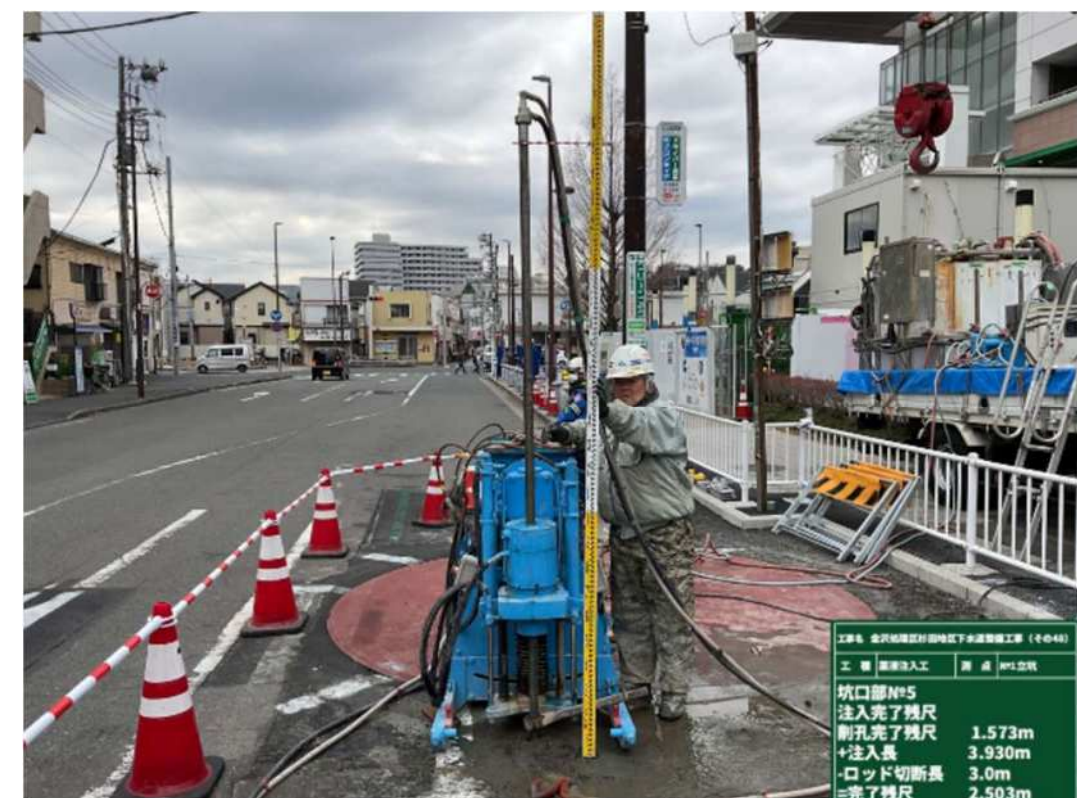
注入完了検尺
