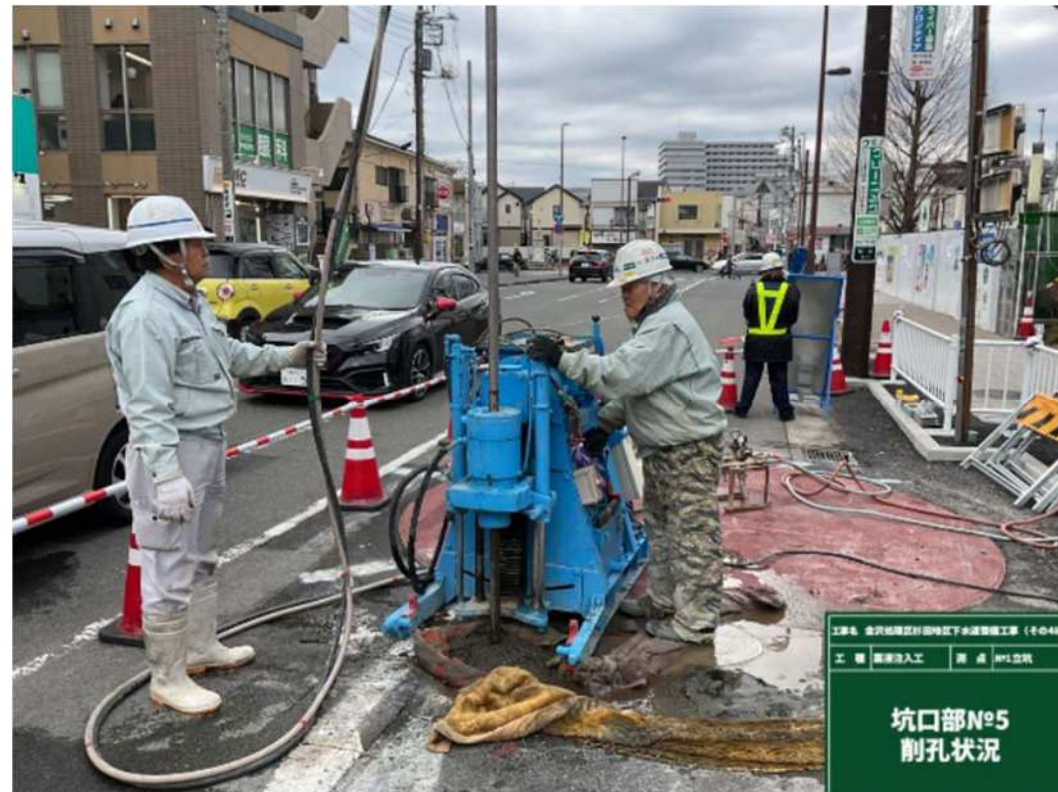
①削孔状況
