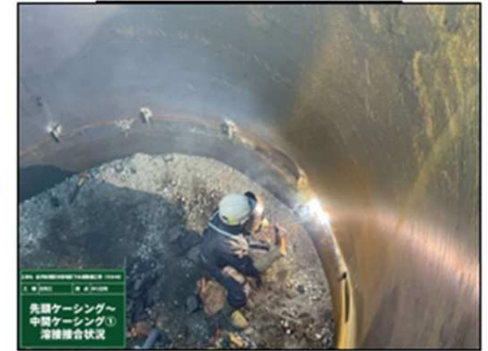
ケーシング溶接
