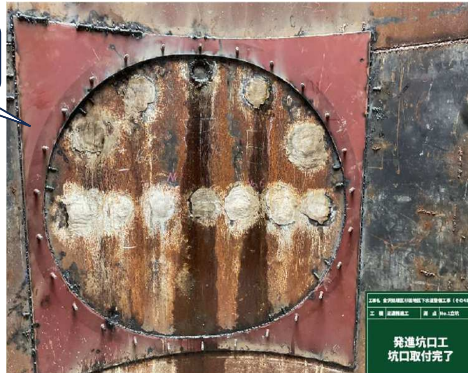
④R型発進坑口リング設置
