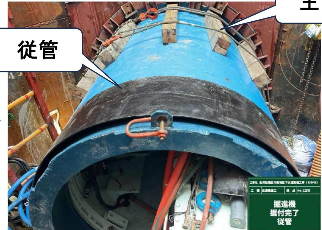
⑨従管据付
