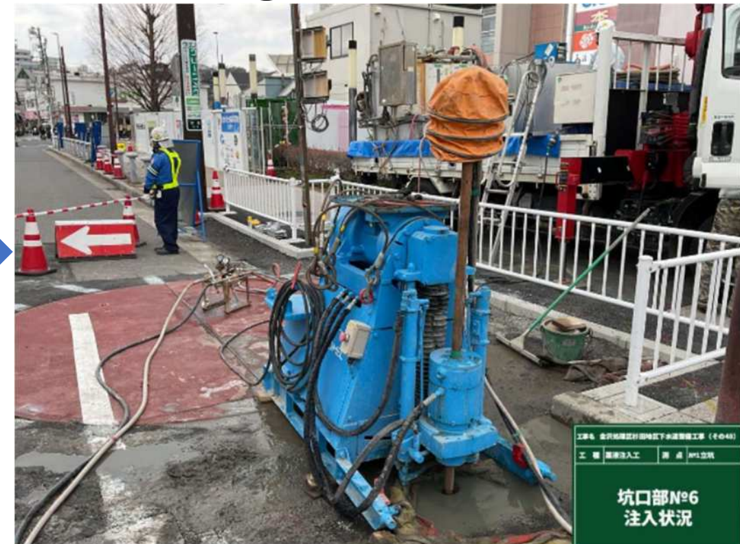
②注入状況
