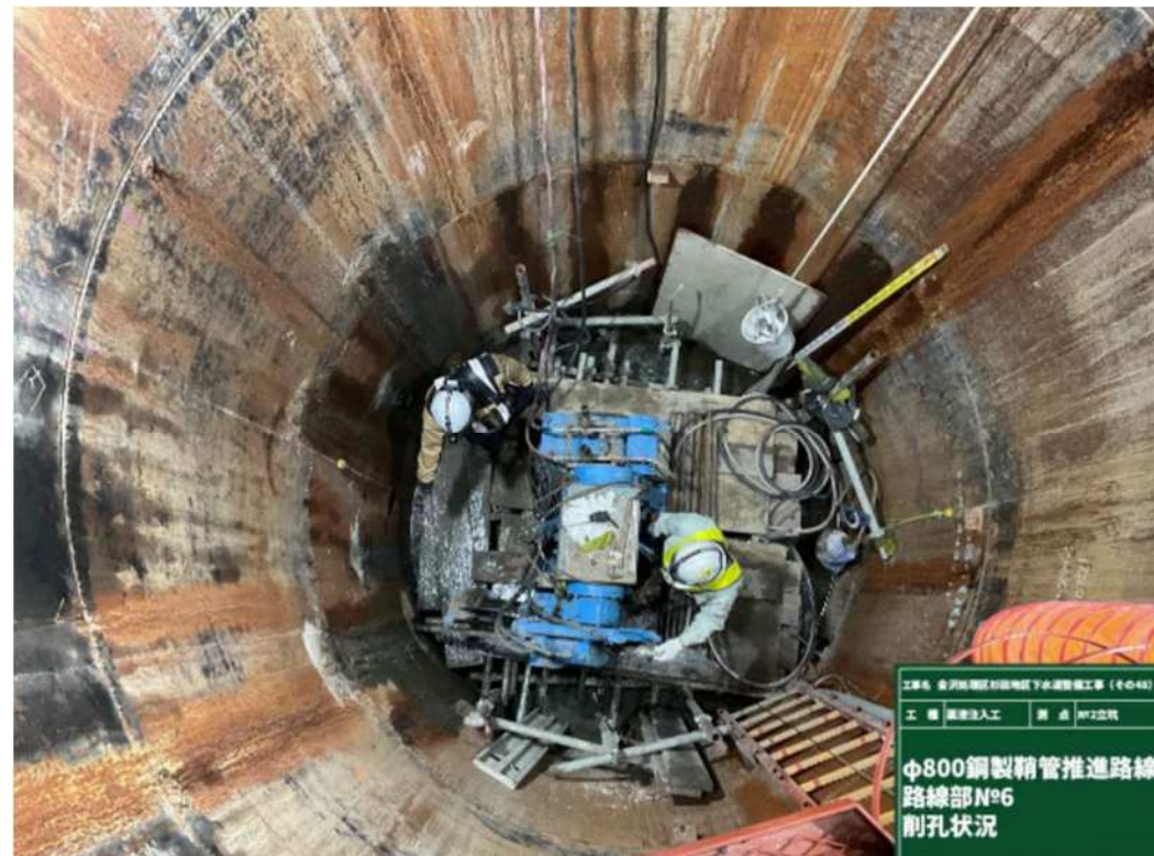
①削孔状況
