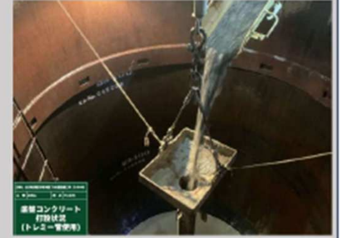
コンクリート打設
