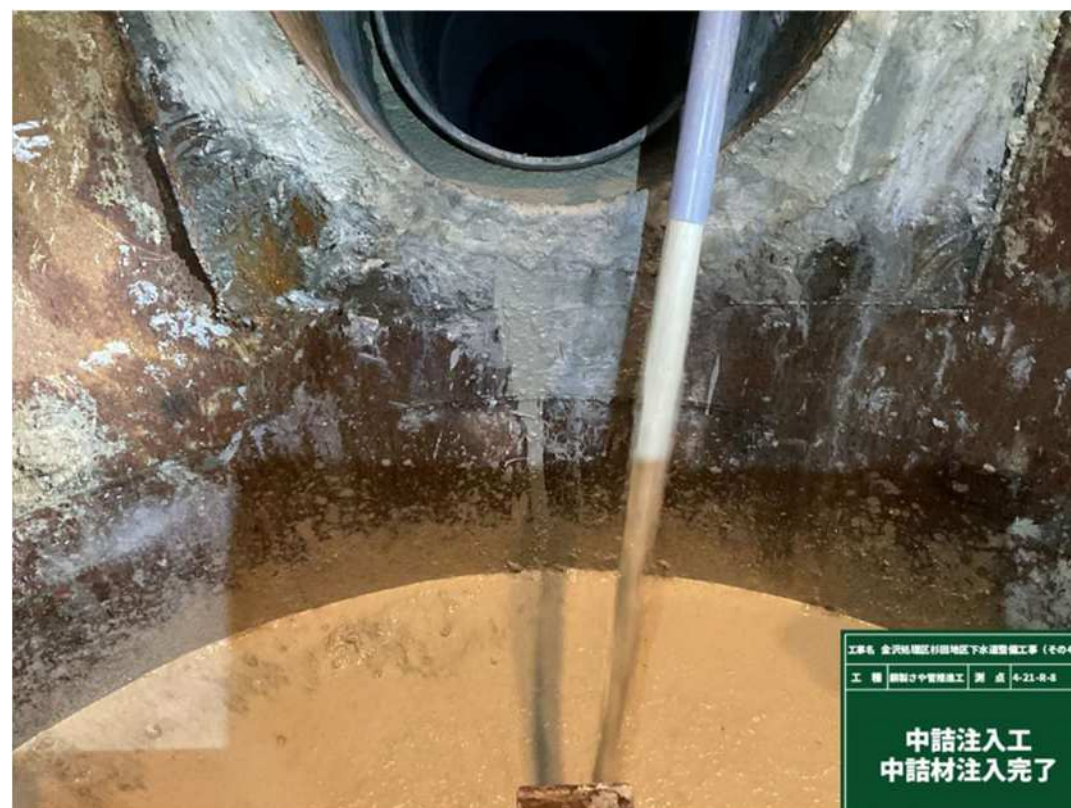
⑯中詰注入
