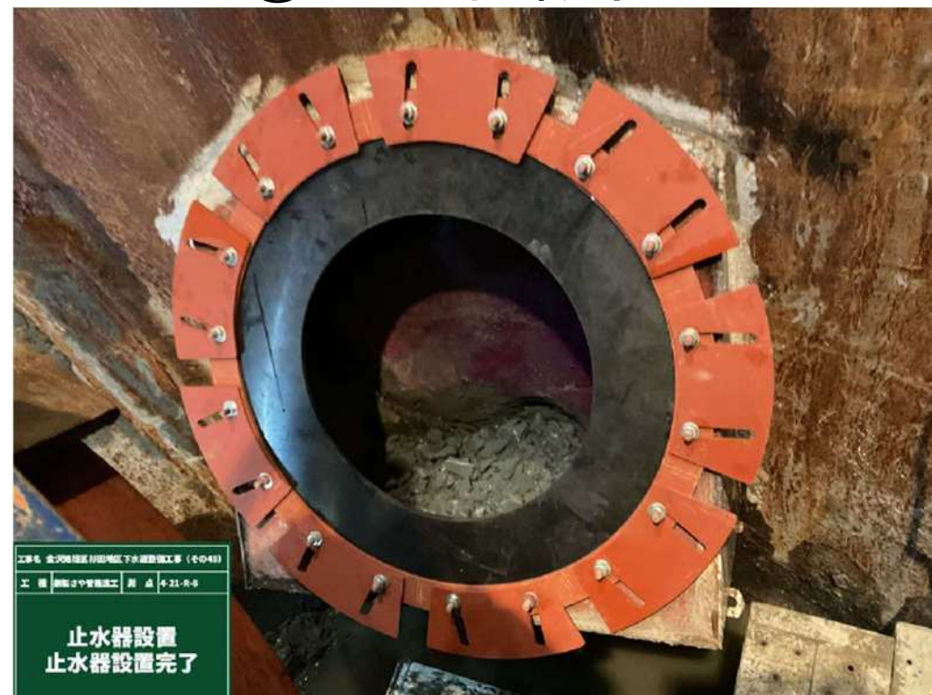
⑦止水器設置
