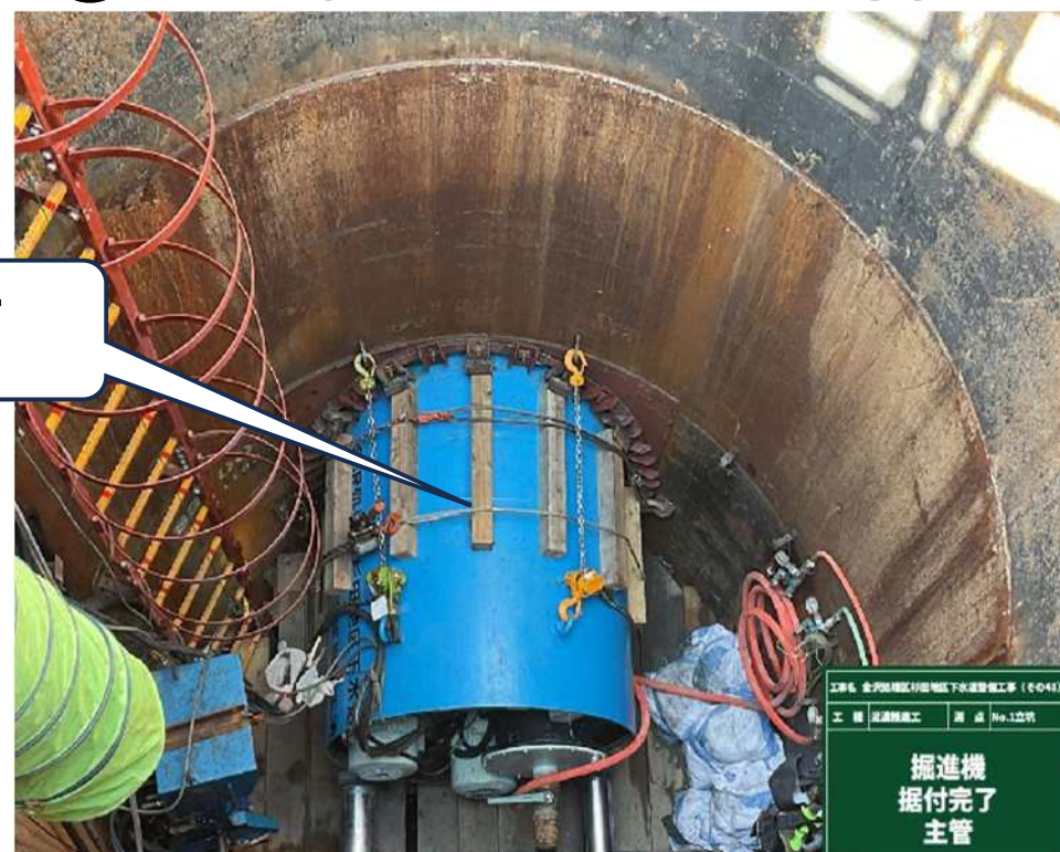
⑥掘進機主管吊降し・挿入
