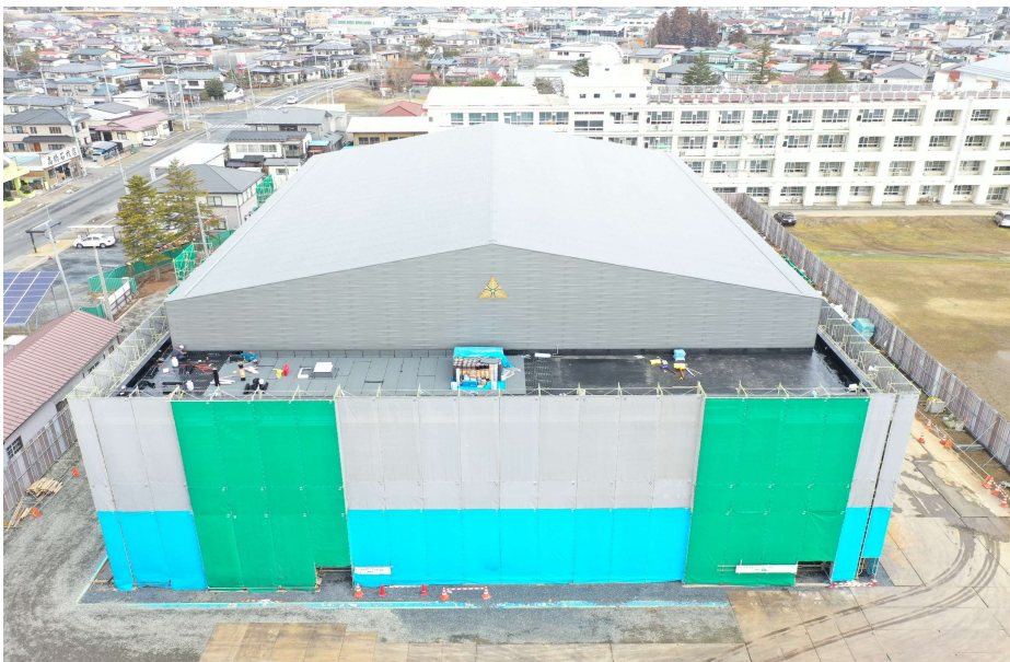
屋内運動場 南側全景
