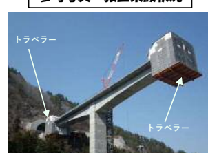
参考写真：張出架設状況
