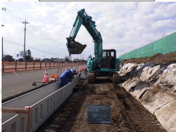
堤脚水路 据付作業
