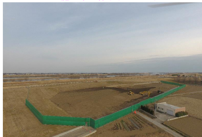
施工中の様子(H30.2.21)
