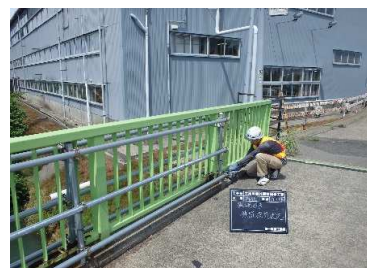
西川大橋の高欄調査状況
