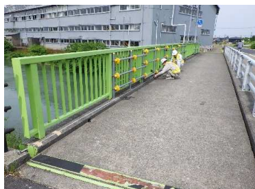
西川大橋の高欄調査状況
