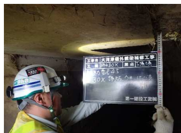
劣化したコンクリートの調査状況
