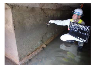
劣化したコンクリートの調査状況
