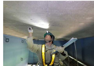
橋のコンクリートの調査
