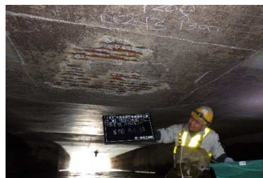
鴻巣橋の現在の コンクリートの状態
