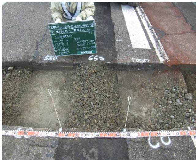
コンクリート版埋設状況
